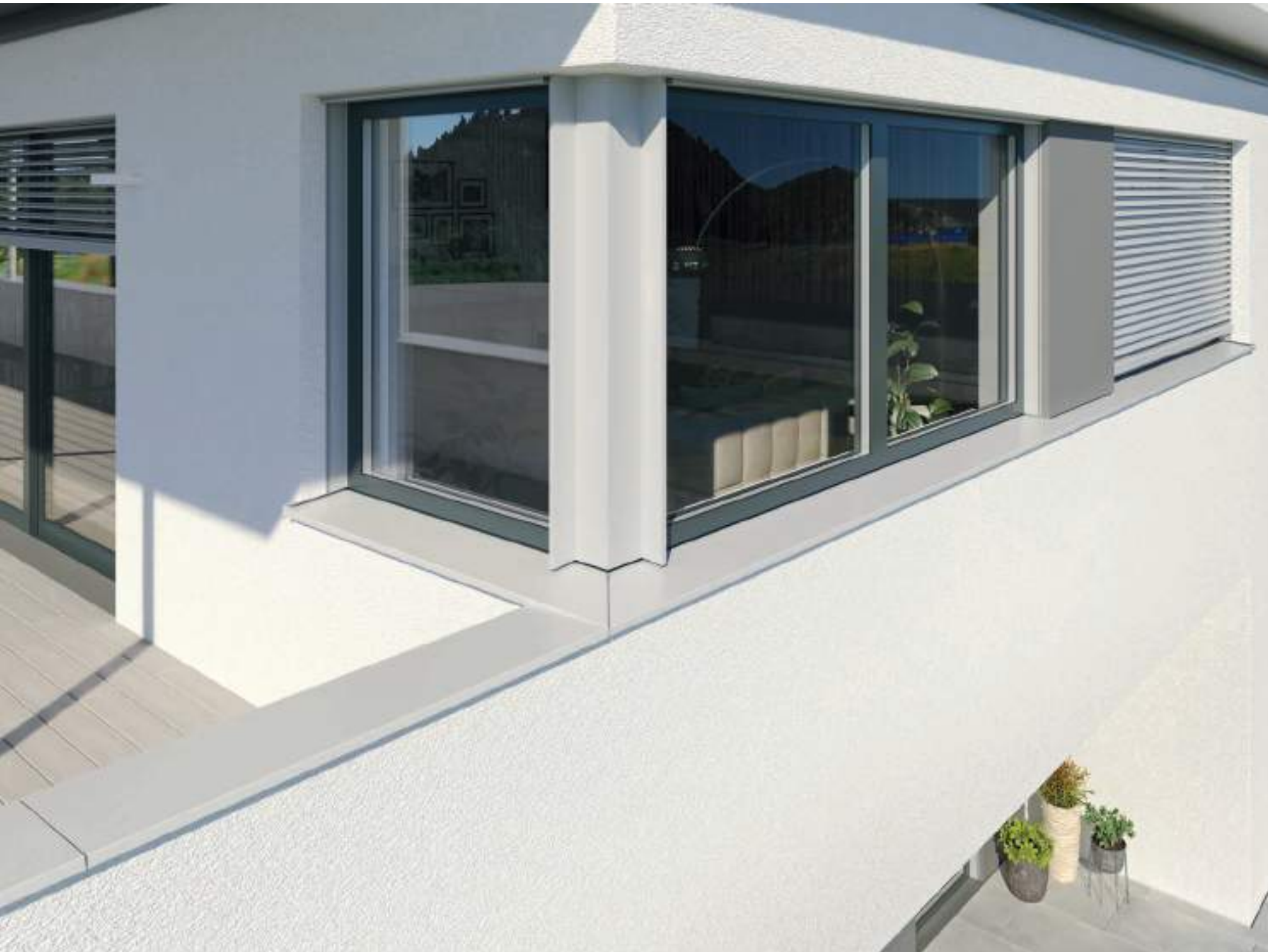
puritamo 210M - Übergang Mauerabdeckung auf Fensterbank
