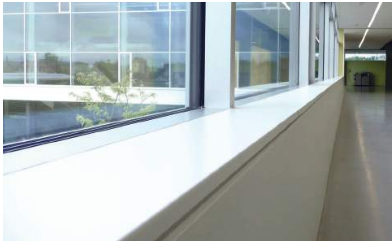
stumpfe Anbindung mit Anschlussprofil
